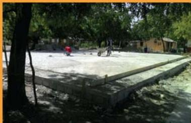
La platea es la base de hormigón armado encima de la cual se ensambla el albergue móvil y modular.
