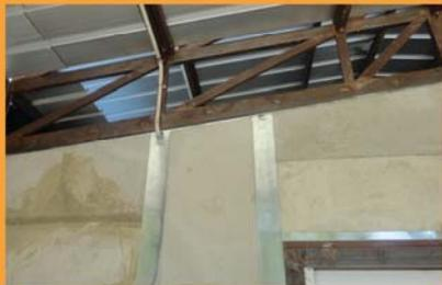
El Techo está conformado por láminas modulares de aluzinc (más resistentes de las más comunes de zinc), que se apoyan en una estructura de tjerillas, vigas y columnas desarmable que soporta el techo. El sistema está reforzado por una estructura metálica anclada a las paredes, resistiendo a vientos huracanados de hasta 200km/h. Habitat para la Humanidad, ha desarrollado una pequeña ficha técnica donde se explica la resistencia de los diferentes componentes del albergue a la comunidad.
