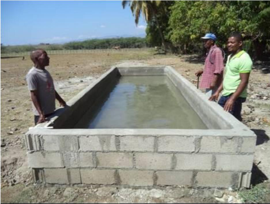
Figura 9. Pileta construida en refugio de las Terreras para almacenar agua destinada al ganado cuando estén en los refugios
